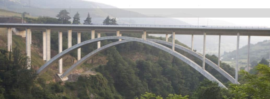
Viaducto del Cieza Cieza bridge
