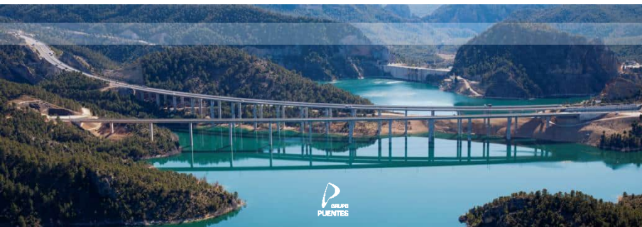
Viaducto del Istmo de Contreras Istmo de Contreras bridge
